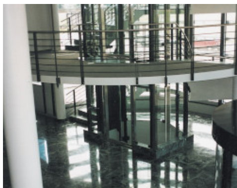
Δάπεδο από πράσινο μάρμαρο Alpi στο Λόμπι εισόδου της Rolex (Biemme - Ελβετία)
